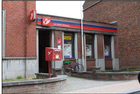
Figure 614 : Photographie, poste de Rebecq (Source : Agora, 2011)
